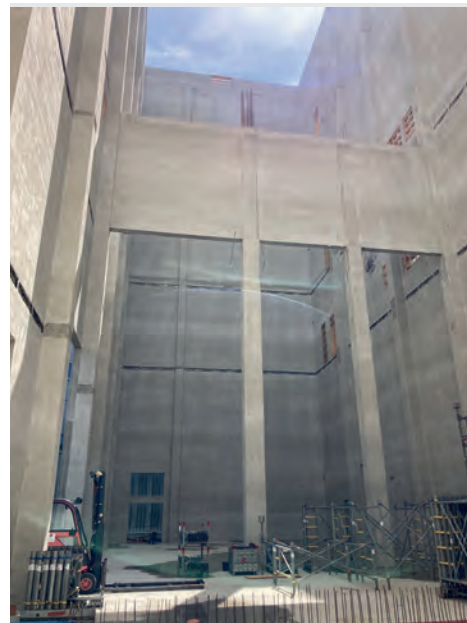
Afb. 7 In het nieuwe gebouw moeten de betonverdiepingsvloeren nog worden aangebracht.
