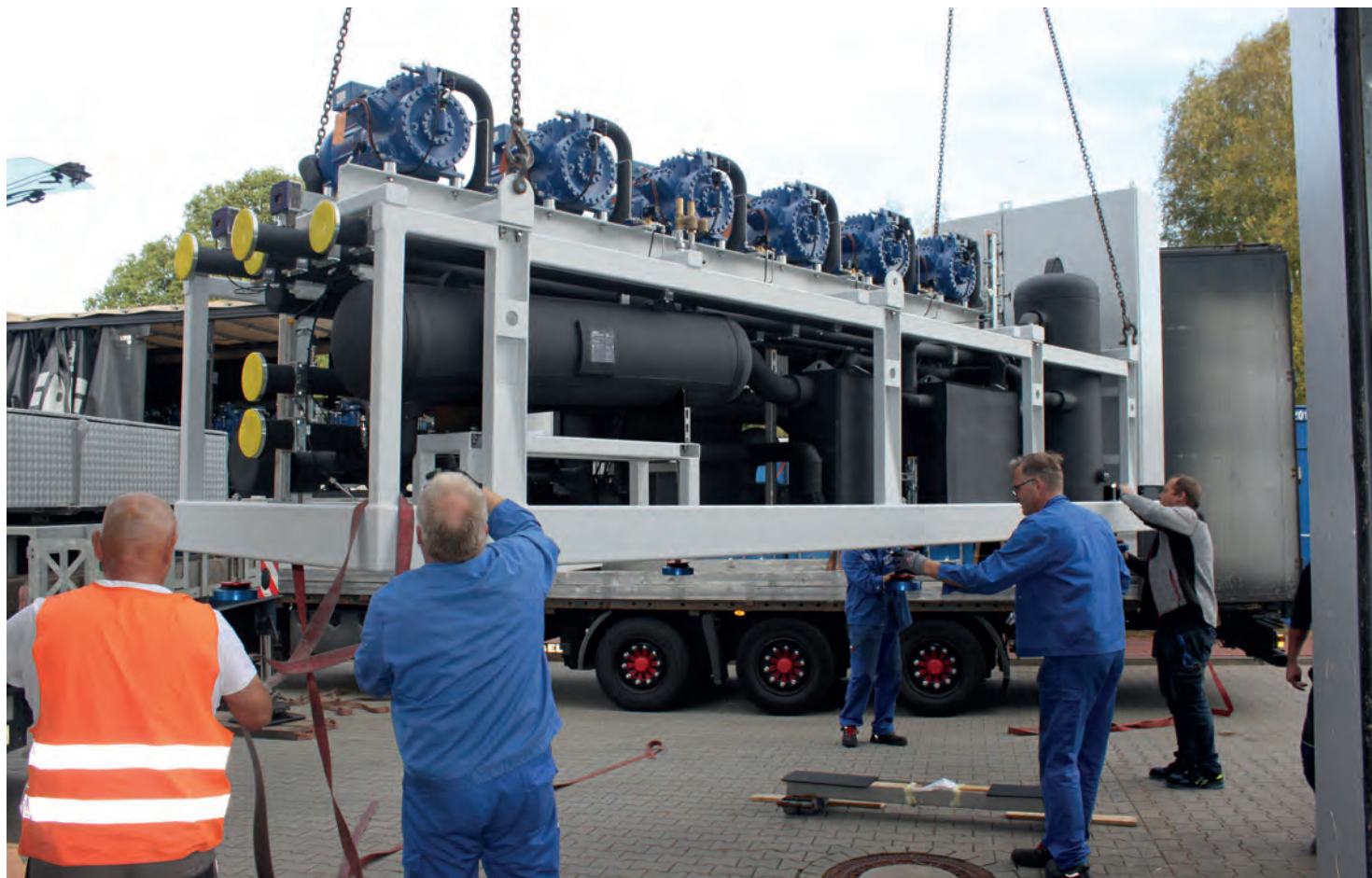
Afb. 1 De warmtepomp wordt op de plaats van bestemming van de vrachtwagen gehesen.
