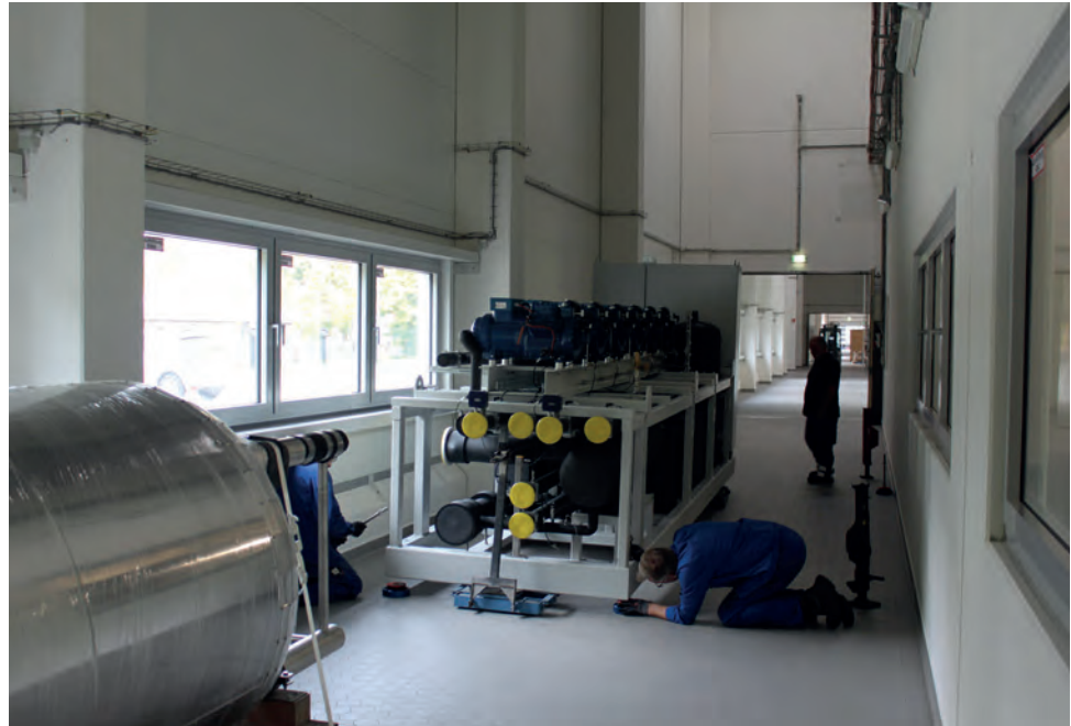
Afb. 2 Lübbers-monteurs installeren de warmtepomp.
